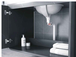
Floor drain 地排
